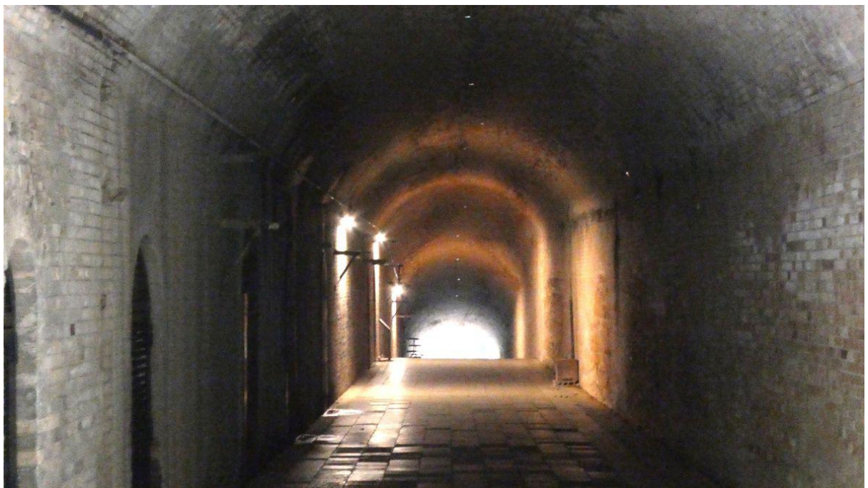
【上：要塞の切通し、下：レンガのトンネル】
