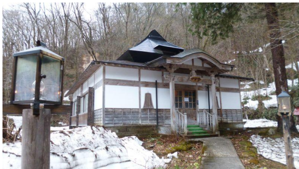
【泊まった離れ 左右にランプが点いている】
