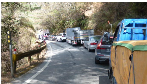
【崩落による工事中通行止めの待ちの車列】
