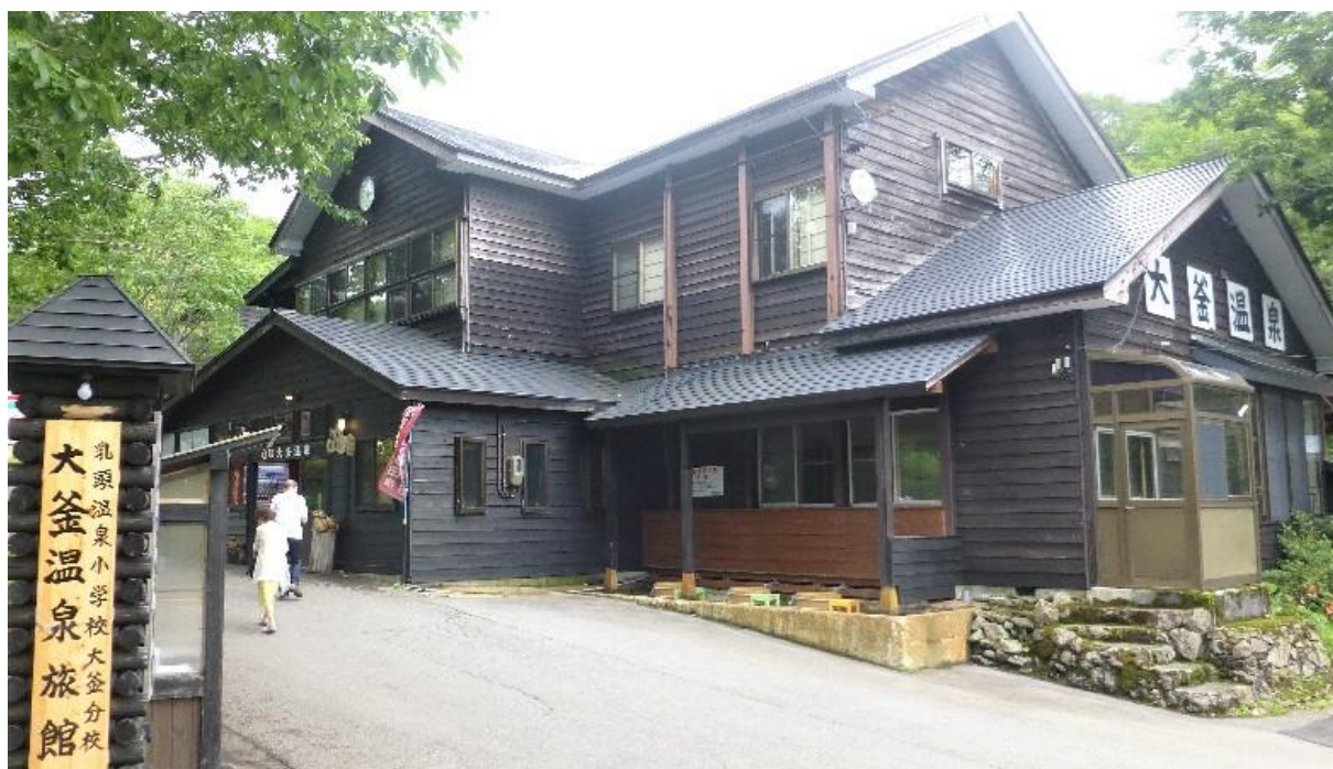
【大釜温泉旅館の小学校の校舎を移築した建屋 左に「乳頭温泉小学校大釜分校」の看板】
