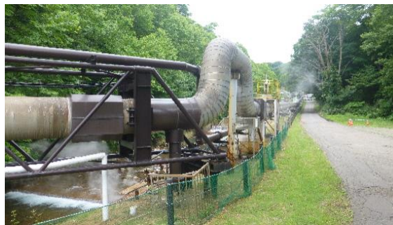
【松川温泉から地熱発電所への蒸気パイプ】
