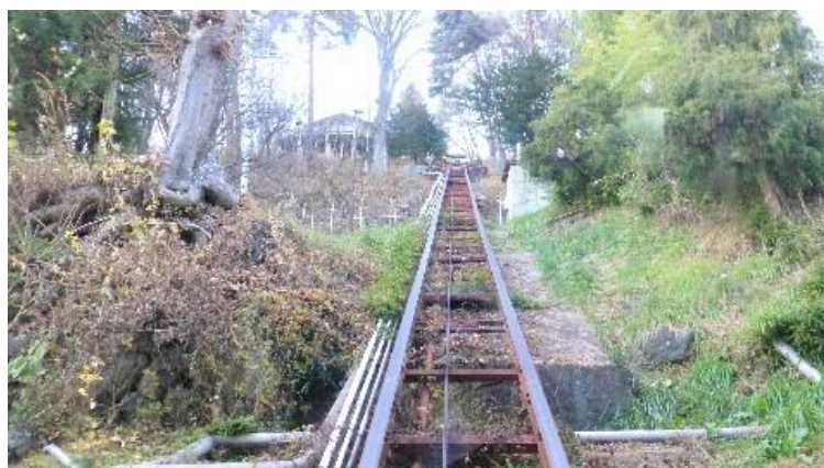
<登山電車の線路 上に温泉棟がある>
