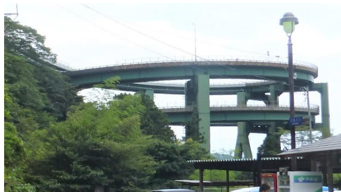
<国道 414 号線のループ橋>
